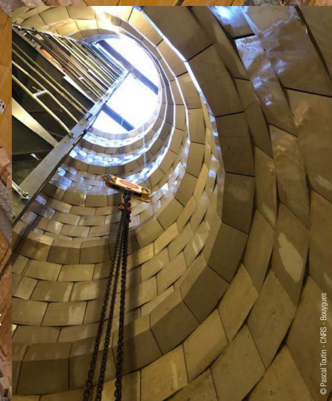
Vue de l'intérieur du puits une fois terminé. On distingue les claveaux en pierre maçonnée.
