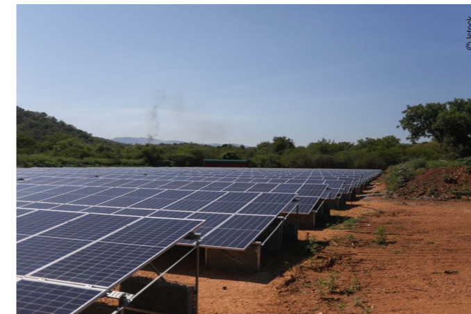
Installation de panneaux solaires en Afrique
